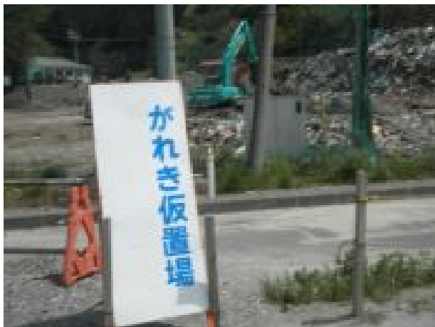
写真3-2 がれき仮置場の看板
