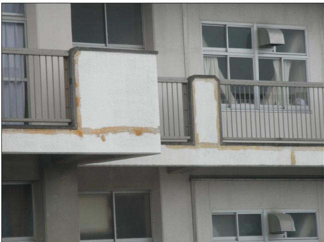
写真23 中村小学校 ベランダ立ち上がり部の亀裂
