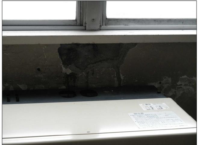
写真21 中村小学校 窓枠下のコンクリート欠損
