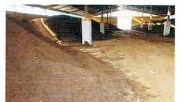
Q 飯田市堆肥センター 内部
