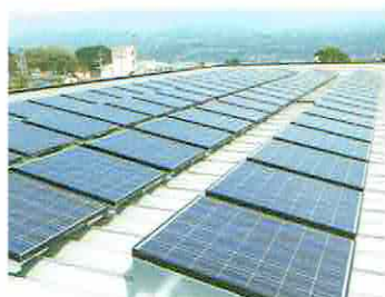
3～20kW容量ほどの 太陽光発電の設置
