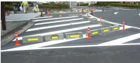
ポストコーン、歩車道境界ブロック
