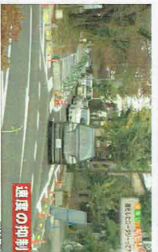
ラウンドバウト △信号がなく 無車線移動がない △直線道路とし 速度抑制して安全確保
