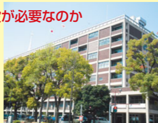
2009年に50億円かけて耐震補強工事済みの現市庁舎。「今後50年間は使える」と市長が太鼓判。
