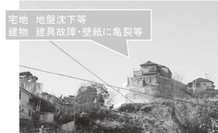
住宅地 地盤沈下等 建物 建具故障・壁紙に亀裂等
