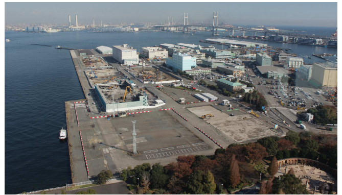
誘致先として名指された山下ふ頭(中区)
